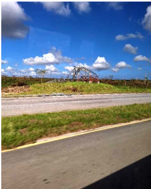
Umgestürzter Starkstrommast
