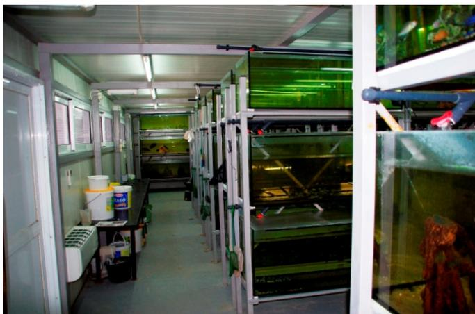
Die Be- und Entlüftung erfolgt über Schiebefenster an beiden Längsseiten der Halle, die Beleuchtung über T8-Leuchtstoffröhren, die durch LED teilweise ersetzt werden.
