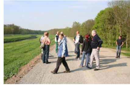
der sanierte Damm am Luppegraben
